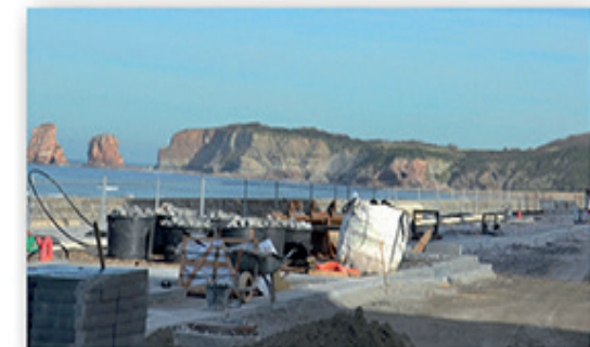
Chantier bd de la Mer Obraak Itsas etorbidean
